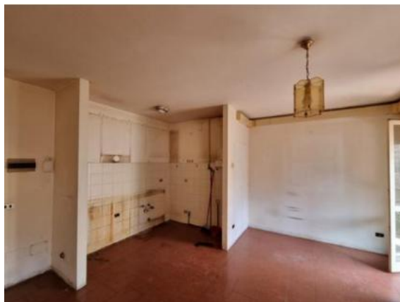
Figura 1 - Stato dell'appartamento prima dell'intervento di riqualificazione eseguito da MM.
