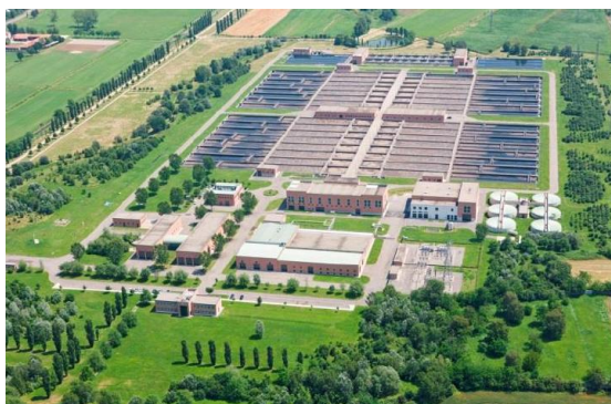
Figura 5 - Vista dell'impianto di depurazione di Nosedo.
