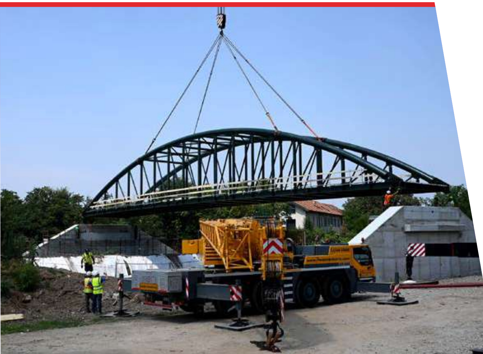
Il varo del ponte pedonale sul Lambro
