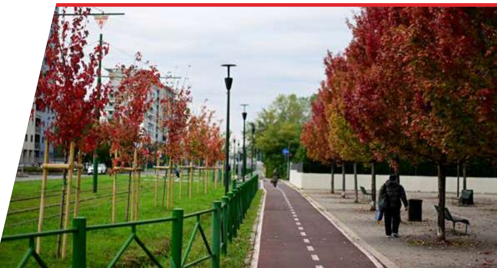
Sistemazioni urbane lungo la nuova Metrotranvia Nord
