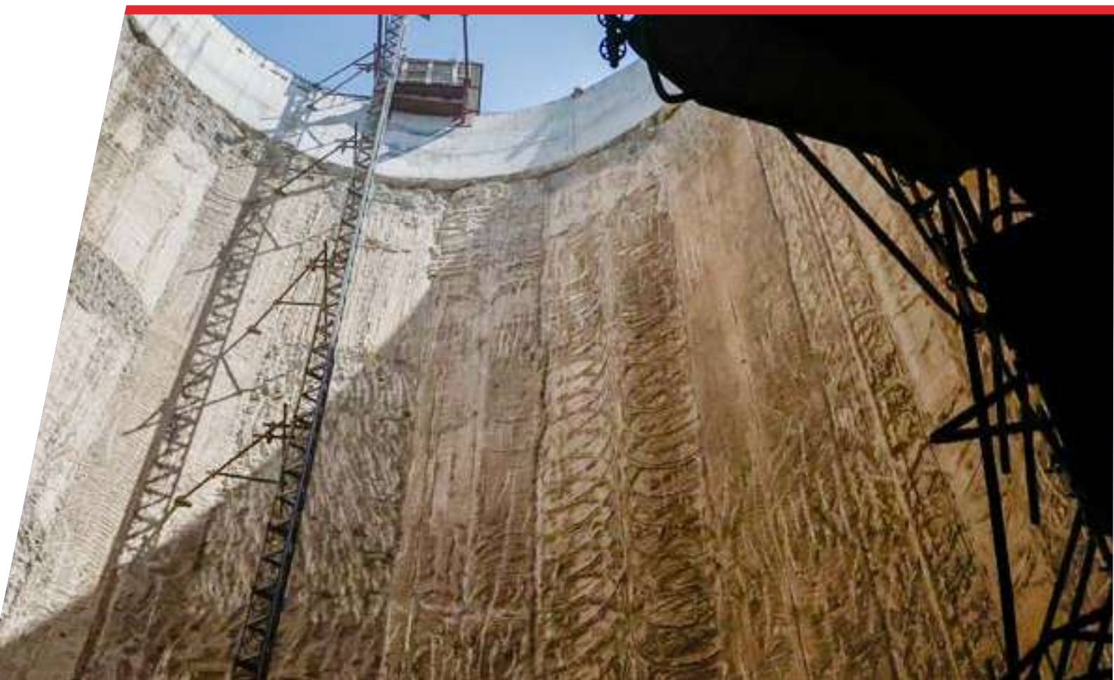
Lavori sulla metro Linea 1 di Napoli
