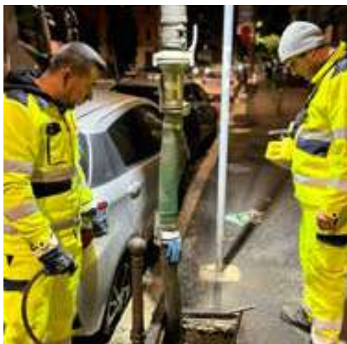
Figura 4 - Operatori durante la pulizia delle caditoie.
