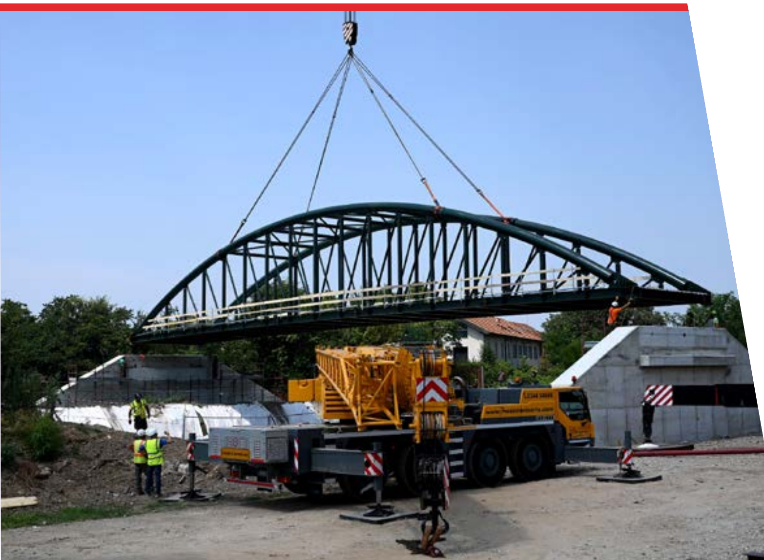
Il varo del ponte pedonale sul Lambro
