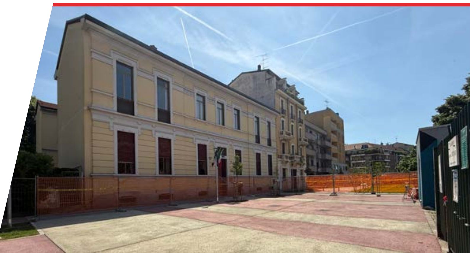
Pavimentazione drenante in via Toce
