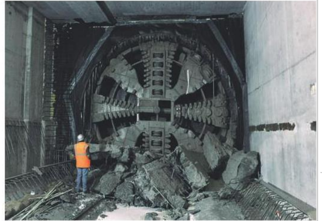
Inarrestabile Sopra, la talpa "Stefania", così ribattezzata dal sindaco di Milano Giuseppe Sala, fa il suo ingresso alla stazione Susa. Era il 2 maggio scorso. Ha scavato senza sosta e in due settimane ha realizzato 256 metri di galleria
