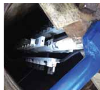
Operazioni di manutenzione pozzo
