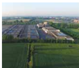
Impianto di depurazione di Milano San Rocco
