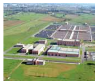
Impianto di depurazione di Milano Nosedo
